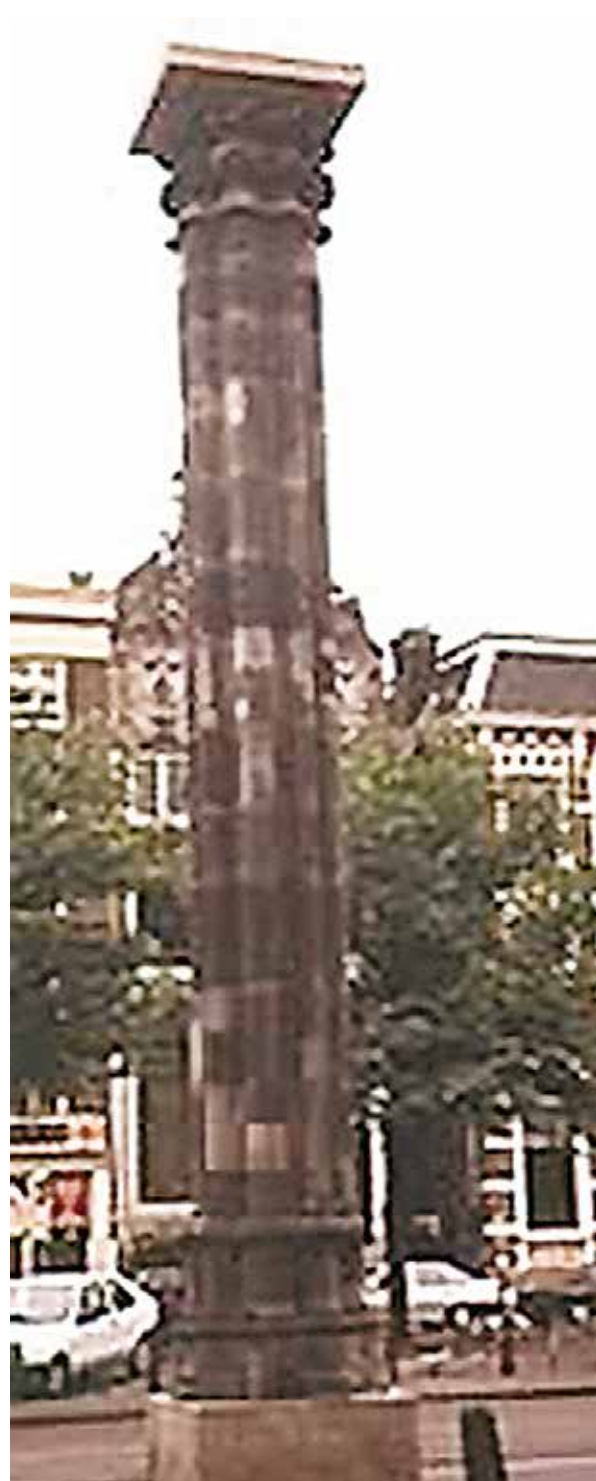
Kolom overgebleven nadat de kerk totaal was afgebrand
